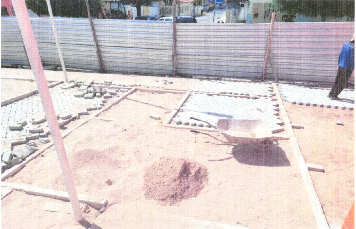
FOTO 26 - GUIA, DIVISÓRIA, EM MEIO-FIO PRÉ MOLDADO DE CONCRETO SIMPLES (0,12 X 0,30 X 1,00 M), REJUNTADO COM ARGAMASSA DE CIMENTO E AREIA NO TRAÇO 1:3
