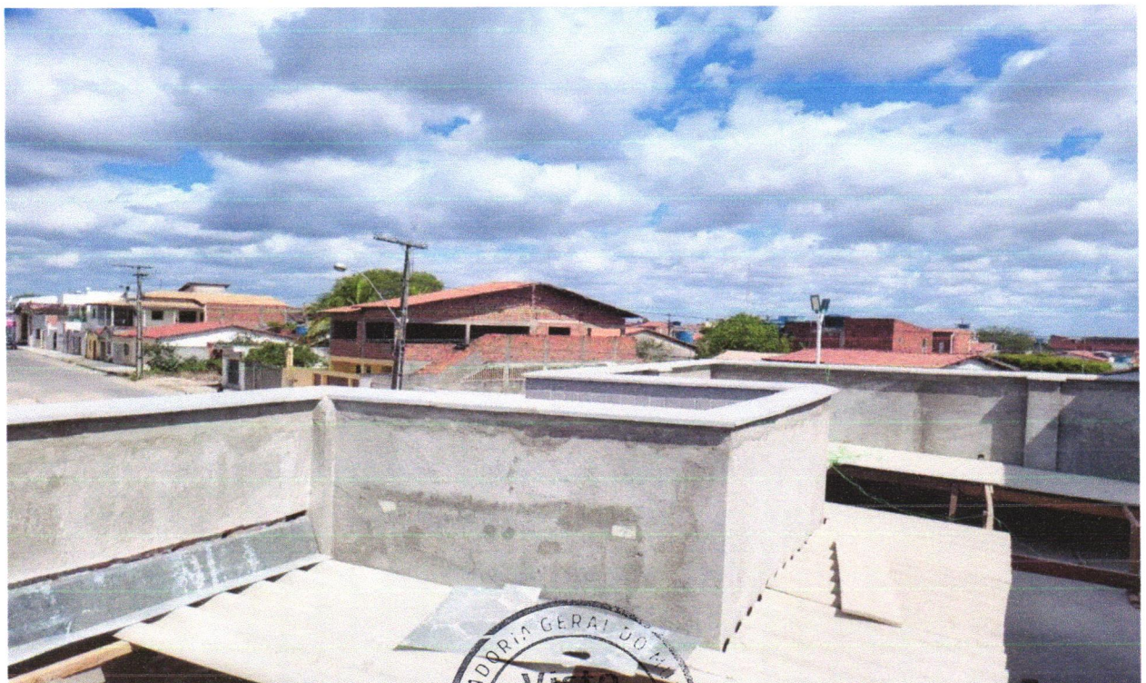
FOTO 08 - CHAPIM DE CONCRETO PRÉ-MOLDADO
