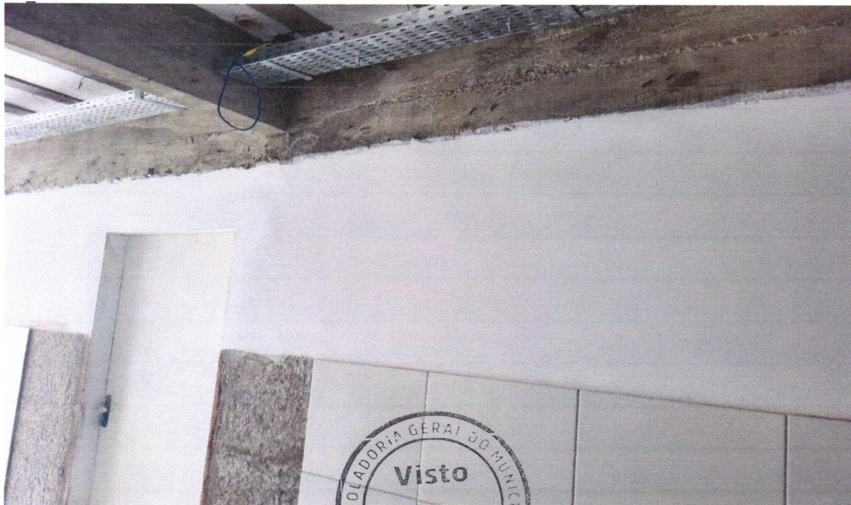
FOTO 12 - APLICAÇÃO MANUAL DE PINTURA COM TINTA LÁTEX ACRÍLICA EM PAREDES, DUAS DEMÃOS. AF_06/2014
