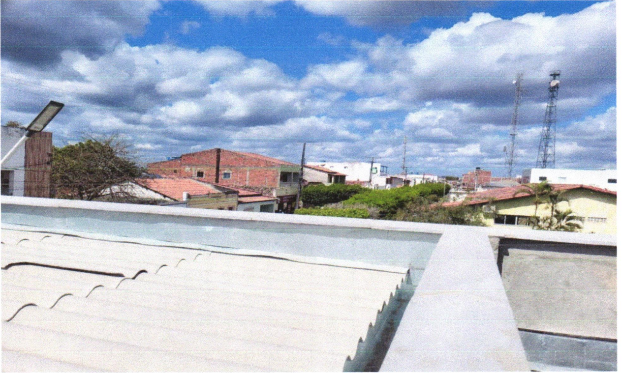
FOTO 06 - CHAPIM DE CONCRETO PRÉ-MOLDADO
