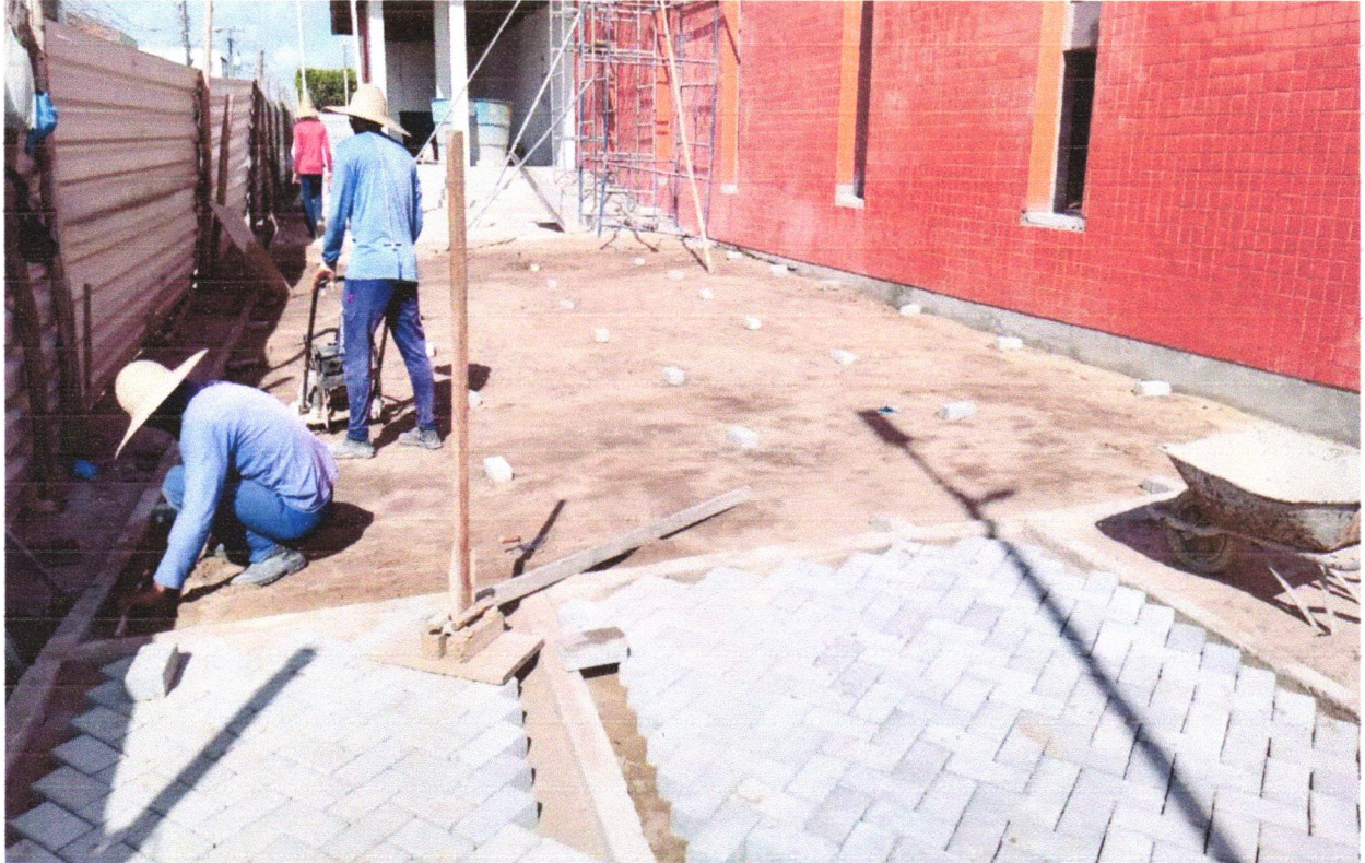
FOTO 20 - EXECUÇÃO DE PÁTIO/ESTACIONAMENTO EM PISO INTERTRAVADO, COM BLOCO RETANGULAR DE 20 X 10 CM, ESPESSURA 10 CM. AF_12/2015
