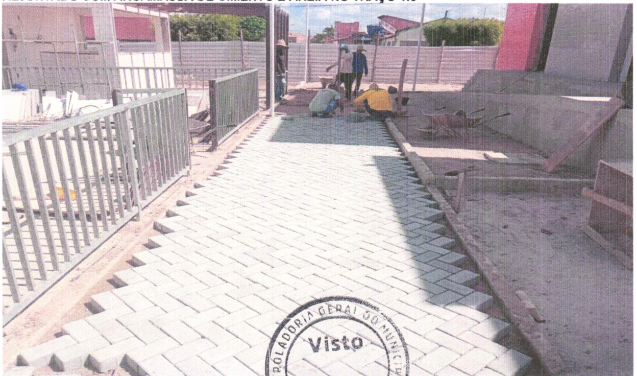
FOTO 26 - GUIA, DIVISÓRIA, EM MEIO-FIO PRÉ MOLDADO DE CONCRETO SIMPLES (0,12 X 0,30 X 1,00 M), REJUNTADO COM ARGAMASSA DE CIMENTO E AREIA NO TRAÇO 1:3
