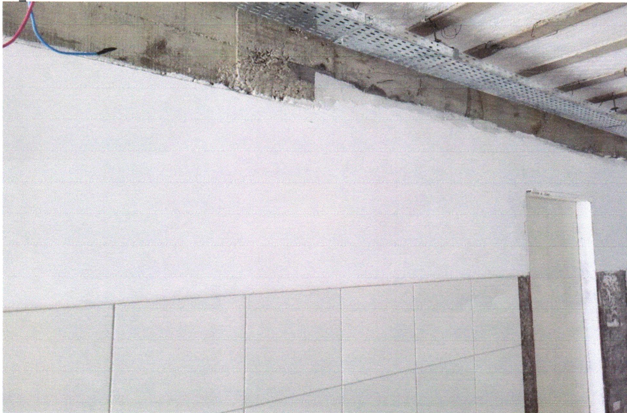
FOTO 12 - APLICAÇÃO MANUAL DE PINTURA COM TINTA LÁTEX ACRÍLICA EM PAREDES, DUAS DEMÃOS. AF_06/2014
