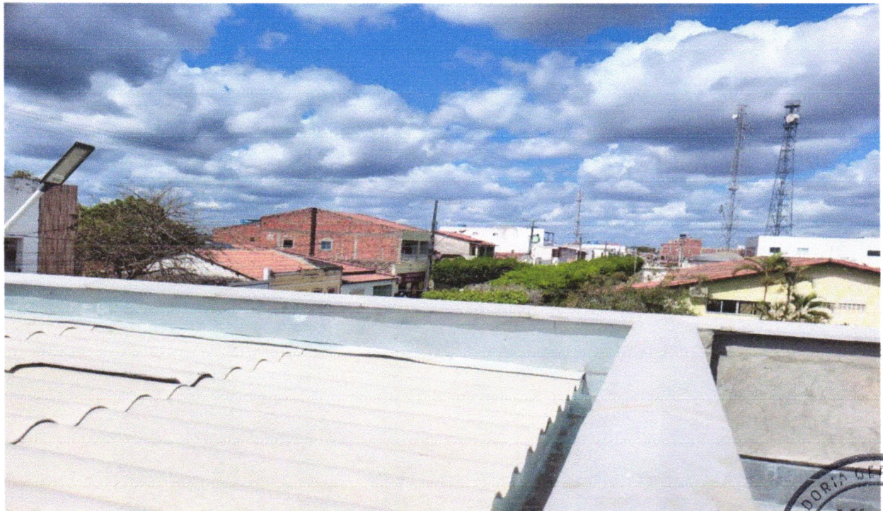
FOTO 14 - RUFO EM CHAPA DE AÇO GALVANIZADO NÚMERO 24, CORTE DE 25 CM, INCLUSO TRANSPORTE VERTICAL. AF_07/2019
