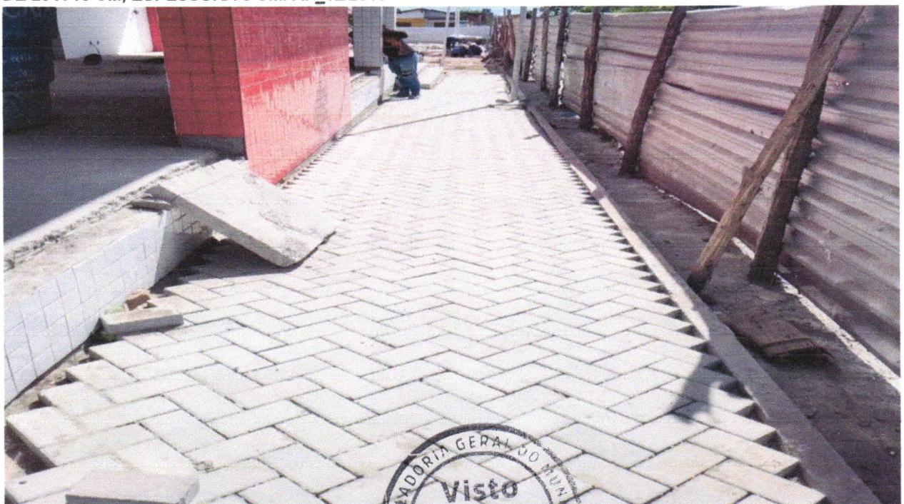
FOTO 24 - EXECUÇÃO DE PASSEIO EM PISO INTERTRAVADO, COM BLOCO RETANGULAR COR NATURAL DE 20 X 10 CM, ESPESSURA 6 CM. AF_ 12/2015
