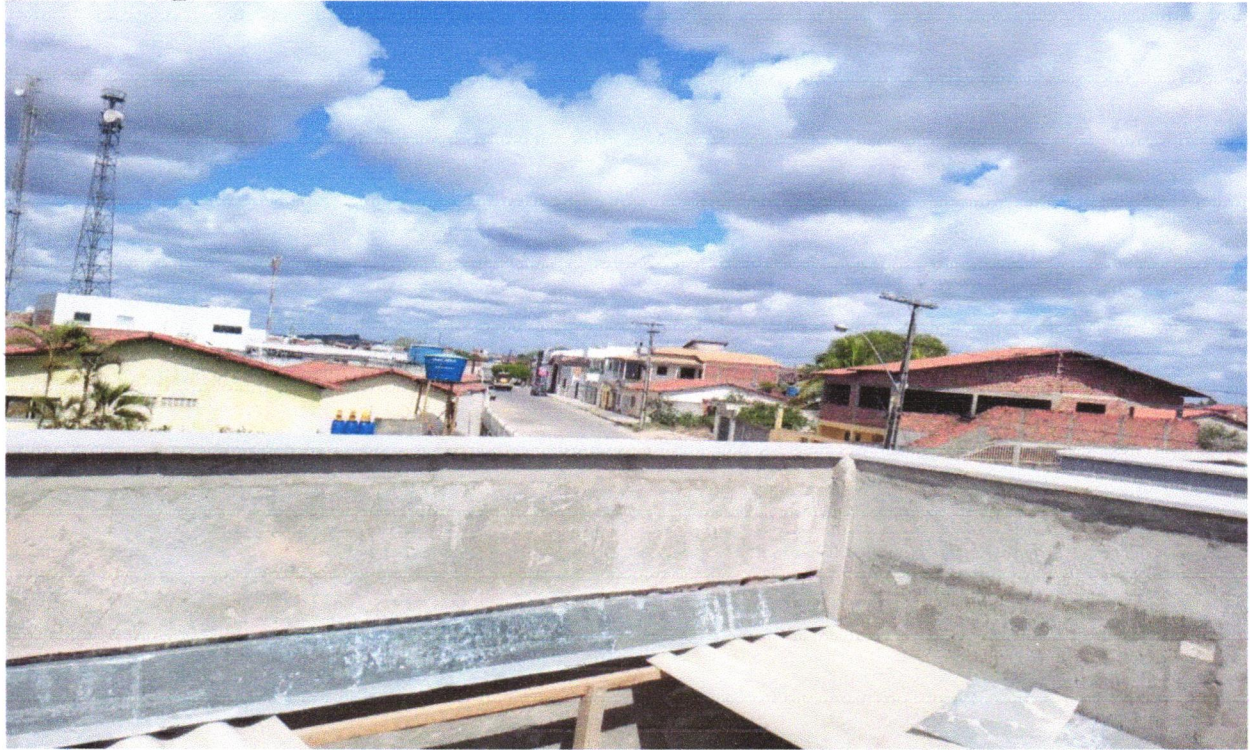
FOTO 14 - RUFO EM CHAPA DE AÇO GALVANIZADO NÚMERO 24, CORTE DE 25 CM, INCLUSO TRANSPORTE VERTICAL. AF_07/2019
